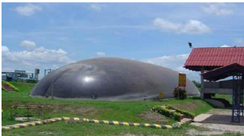
ภาพที่ 2.6 ระบบบำบัดสิ่งปฏิกูลแบบบ่อหมักไร้อากาศ
