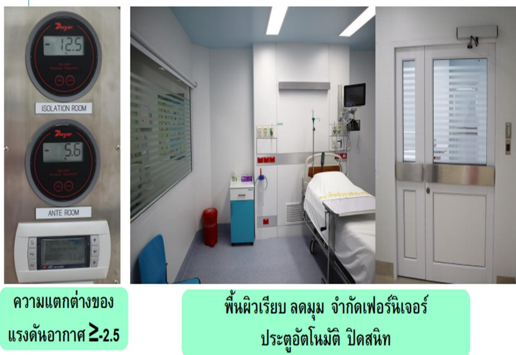
รูปแสดง ห้องระบบจัดการอากาศ Airborne infection isolation room (AIIR)
