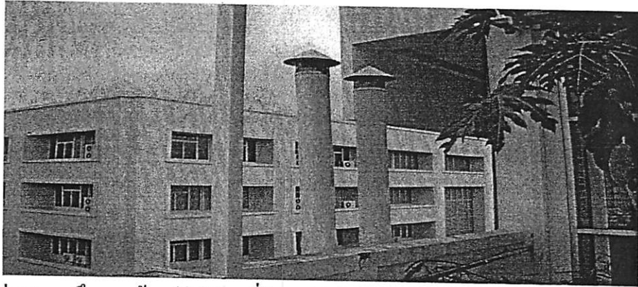
ภาพตัวอย่างสภาพตึกของห้องปฏิบัติการที่มีการปล่อยปล่องควันระบายอากาศไปยังอาคารเรียนด้านข้าง
